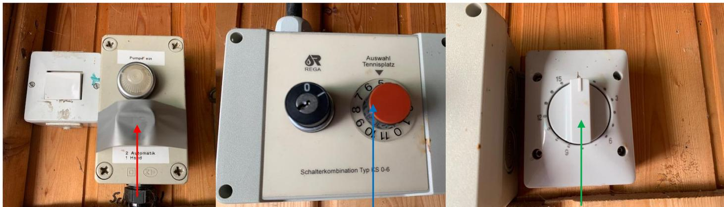
**Pumpe: der Schalter muss auf „Automatik“ eingestellt sein!!**
